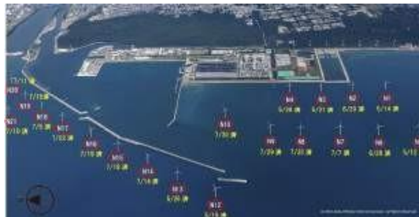
能代港内の設置工事進捗状況 (R3.9.16時点) (AOW提供)
