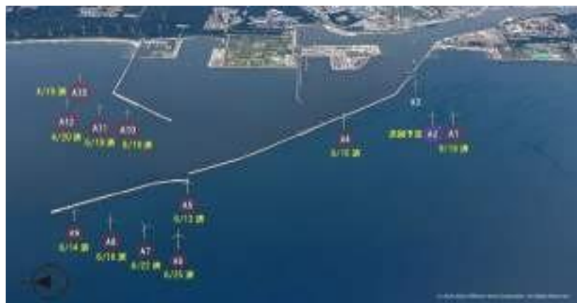
秋田港内の設置工事進捗状況(R3.9.16時点)(AOW提供)
