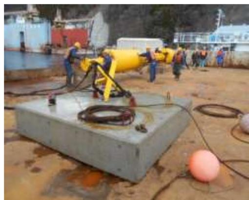
海洋試験後、中間ブイとアンカー部を回収
